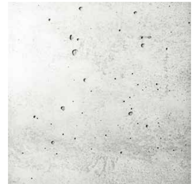
Sichtbeton im Innenraum
