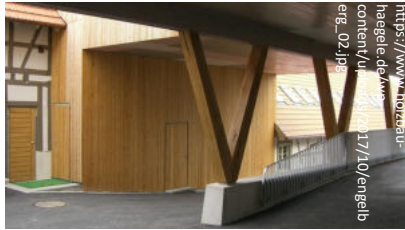
„Fachwerk“- V-Stützen Brettschichtholz Lärche
