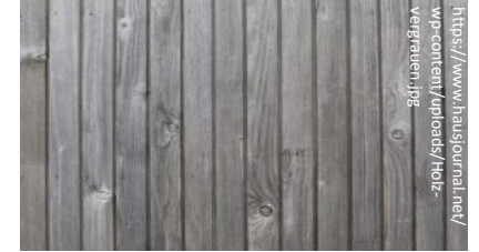
Fassadenlattung sibirische Lärche vergraut
