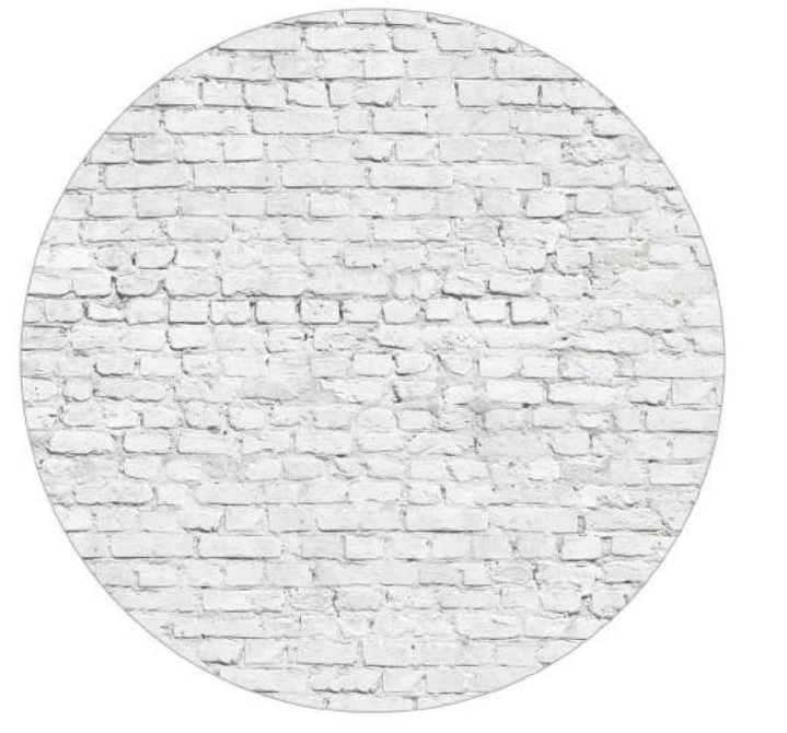
MAUERWERK WEISS GESCHLÄMMT MIT KALK.
