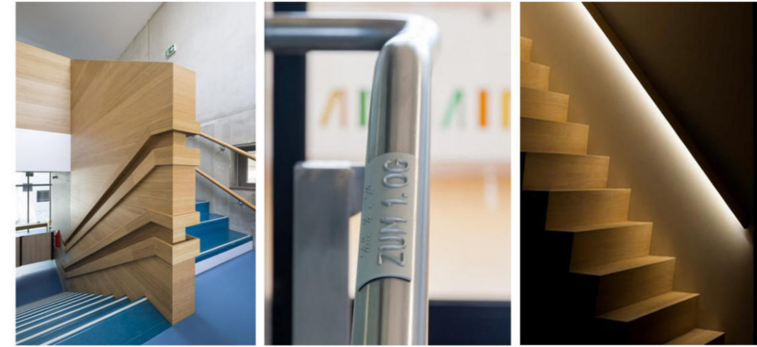
taktile Informationen am Handlauf indirekte Beleuchtung als Orientierung
