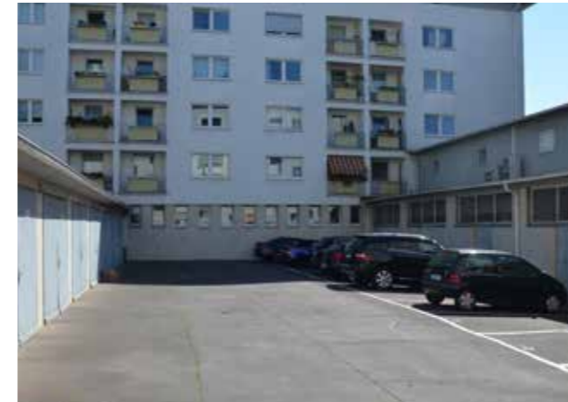
Abb. 94: Hinterhof mit hohem Versiegelungsgrad
