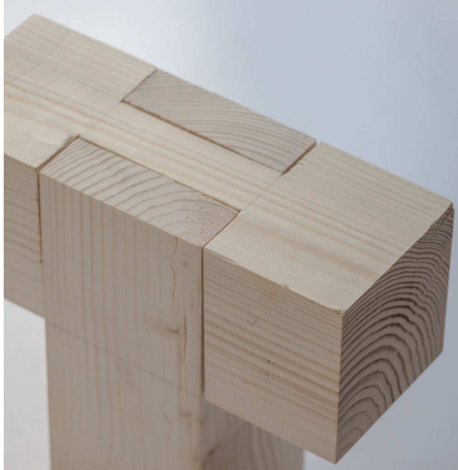
Fügungszeichnung Einhälsung | Joint drawing fork joint
