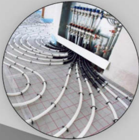
Fußbodenheizung
